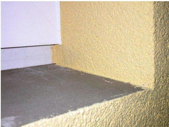
Abbildung 10: Zweite Dichtebene mittels fertig beschichtetem Parapet (Dichtschlemme)
