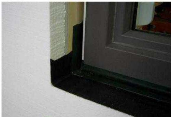
Abbildung 11: Zweite Dichtebene, welche wannenförmig an den Fensterrahmen mittels Folie und Klebeband angeschlossen wird. Seitlich in der Leibung sollte die Folie mind. 6 cm hochgezogen werden
