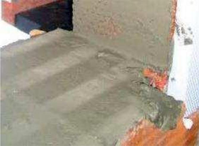
Abbildung 2: Glattstrich auf Ziegelmauerwerk am Parapet, um konvektionsbedingtes Kondensat zu vermeiden
