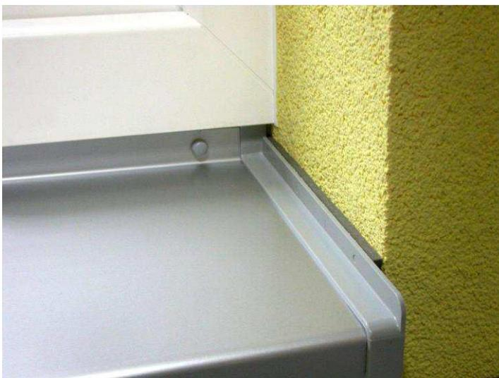
Abbildung 9: seitlicher Abschluss mit vorkomprimiertem Dichtband
